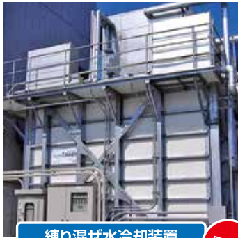
練り混ぜ水冷却装置 クーリングダッシュシステム
