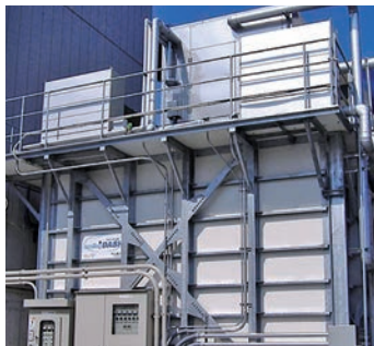
練り混ぜ水冷却装置 クーリングダッシュシステム 日本初
